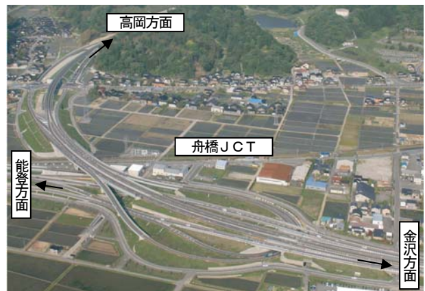
写真-1 舟橋ジャンクションの状況
