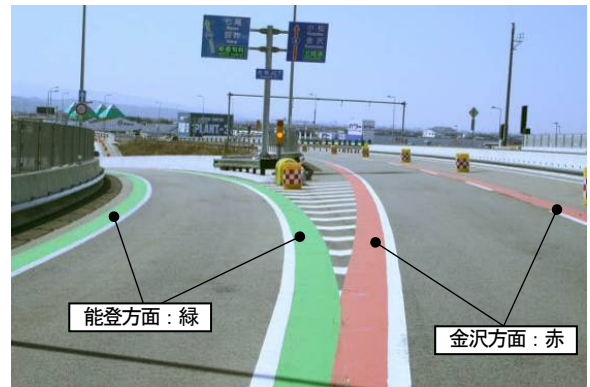
写真-2 施工状況（能登-金沢分岐部）
