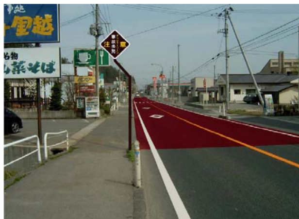
図-1 デンジャーゾーン舗装の例（山形県西川町）
