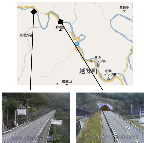
図-4 下流側映像(左) 上流側映像(右)
