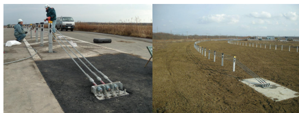
写真-7 端末部（左）とカーブ区間の施工状況（右）
