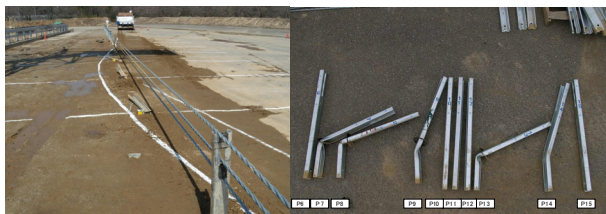
写真-9 衝突後の状況と損傷した支柱
