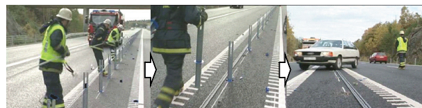
写真-4 緊急時の解放例
