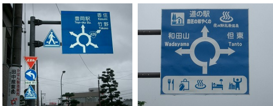
写真-2 矢印形状が統一されていない「方面および方向」標識
