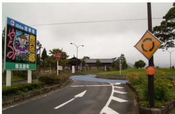
写真-1 「一時停止」「一時停止」, 「ロータリーあり」標識, 環道のカラー舗装
