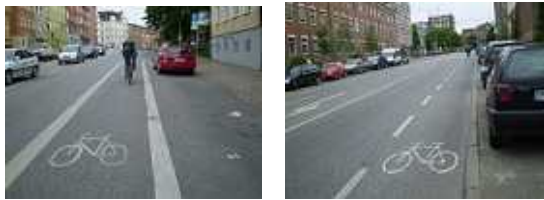
図 - 2 自転車専用車線（左）と自転車保護車線（右）
