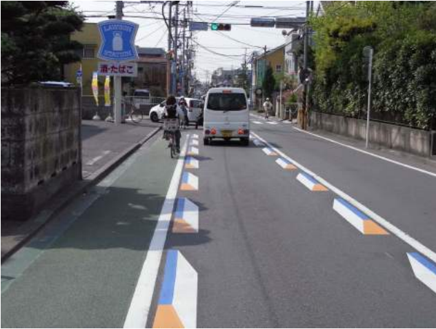
写真- 7 整備全景
