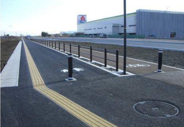
写真- 3 整備全景
