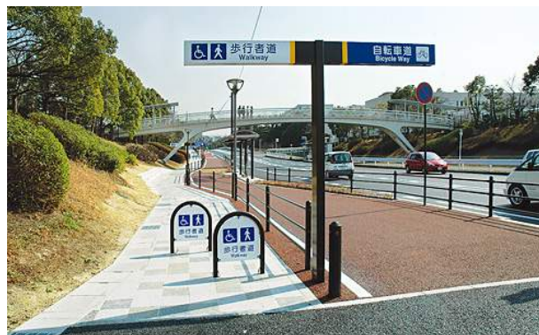
写真- 1 整備全景
