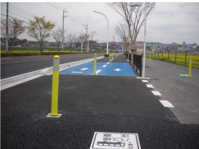
写真- 8 整備全景
