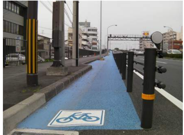
写真- 5 整備全景
