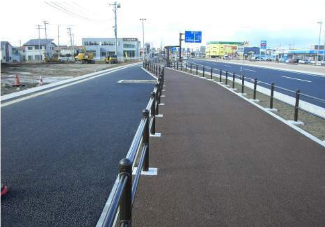
写真- 4 分離用防護柵
