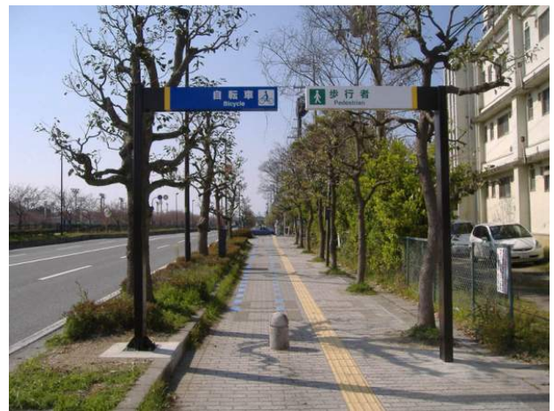
写真- 10 整備全景
