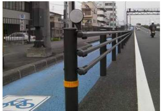
写真- 6 車両用防護柵
