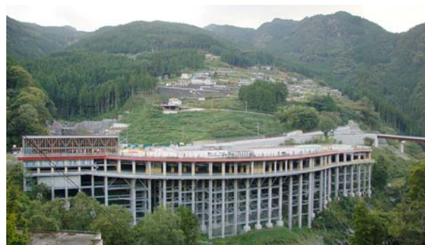
写真-1 対岸からのかずら橋駐車場全景
