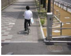
写真 利用されない自転車道
