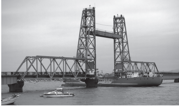
写真-2 筑後川昇開橋 (著者撮影)
