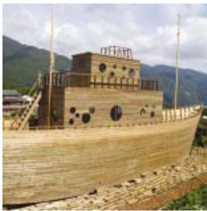
写真1 射手座造船所：4m×850本の間伐材の製材使用
