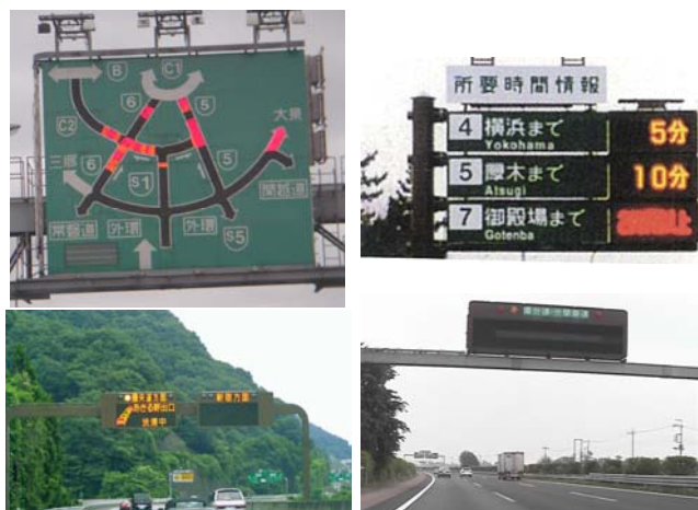
写真-1 図形情報板(左上)、所要時間情報板(右上)、JCT 情報板(左下)、インター流出部情報板(右下)
