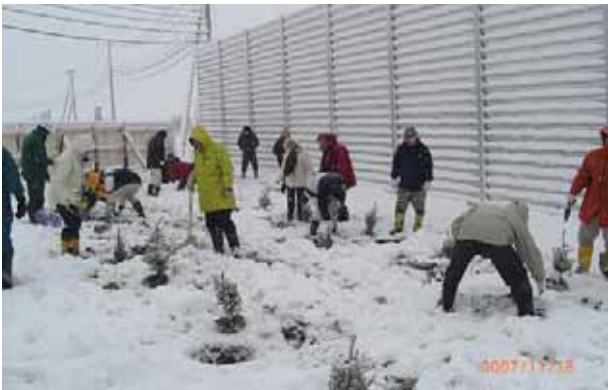
写真 - 3 防雪林植樹の様子
