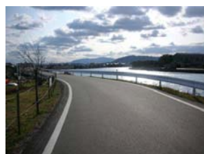
写真5 路側帯が狭いが広いと感じられている道路の例
