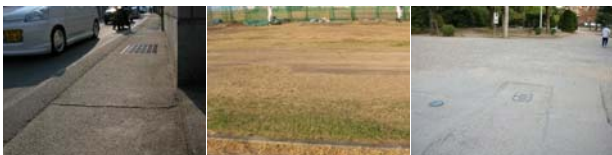
写真10 硬いと評価されたコンクリート舗装の例
