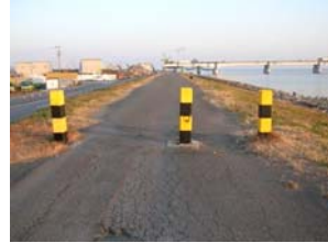
写真3 河川管理用道路
