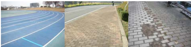
写真7 ゴムチップ舗装の例
