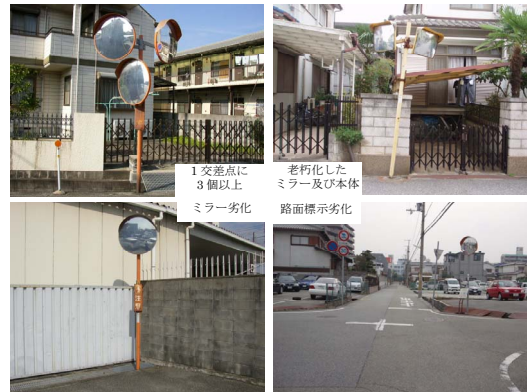
図-4 交通安全対策整備の状況 (例)
