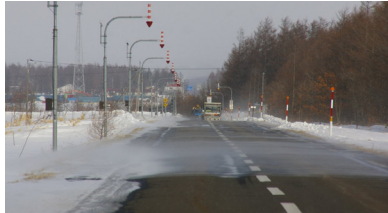
写真-7 防護柵が無く雪堤の形成は抑制される
