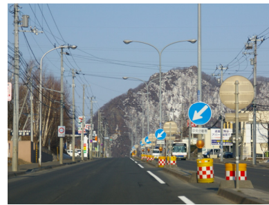
写真-11 分離帯開口部の付属施設
