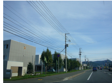
写真-10 セットバックされた電柱
