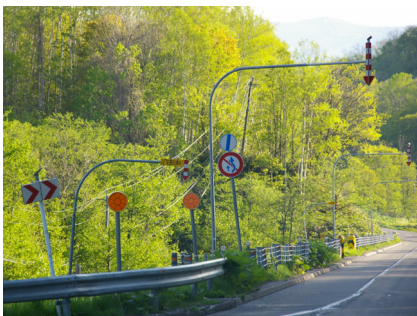
写真-4 ガードケーブル端末部にカードレールや反射板等が設置され煩雑となっている
