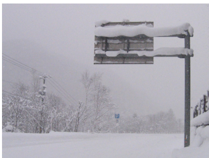
写真-5 片持ち式案内標識への着雪事例
