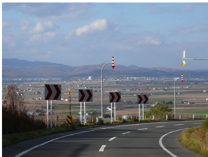
写真-3 シェブロン標識によって、前方の眺望が遮られているが、冬期の路面凍結によるスリップなどの危険のためカーブに設置されている事例が多い
