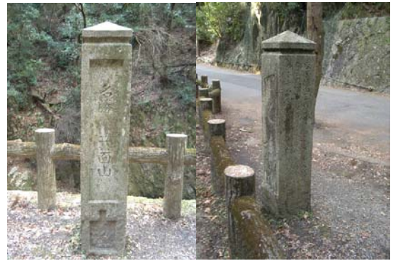
図-6 移設された一之橋の親柱(時雨付近)
