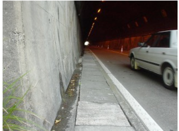
写真-1 未対策の井の岬トンネル
