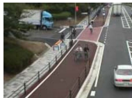
図-3 調査地点の道路状況（整備後）
