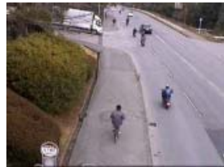
図-2 調査地点の道路状況（整備前）
