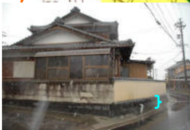
(d) 島町「本村」集落の住宅 (各戸とも石垣2段分の盛土)
