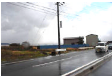
(e) 十六町輪中を横切る県道と出水時に閉鎖される陸閘
