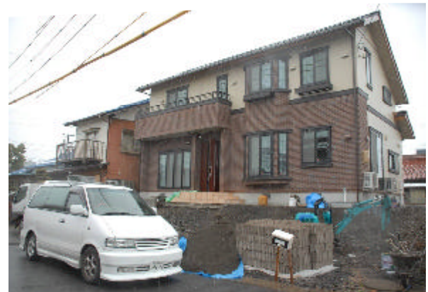
図-6 島住宅での建て替え時の盛土施工状況
