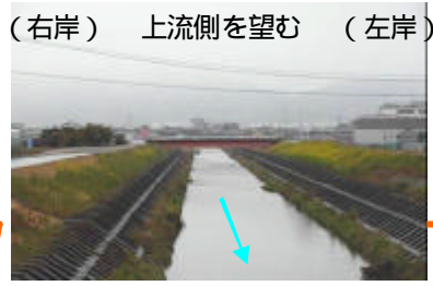
(b) 右岸堤が低い(左岸にある市街地(=旧大垣城下)を防護)
