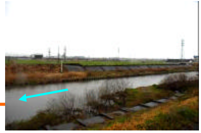
(a) 大谷川右岸に存置されている越流堤(左岸から望む)
