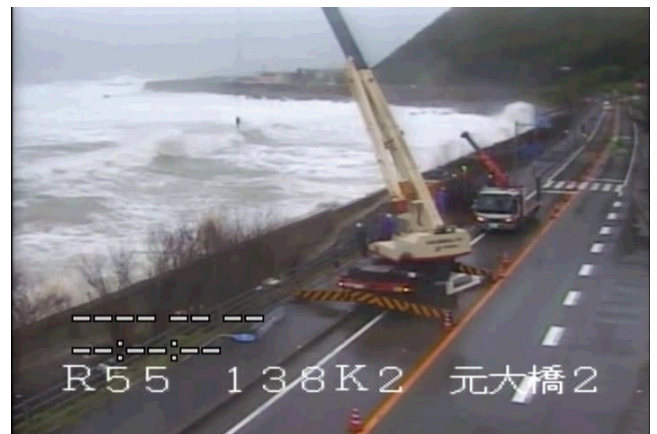
図3 越波発生 0.5秒前の CCTV 映像
