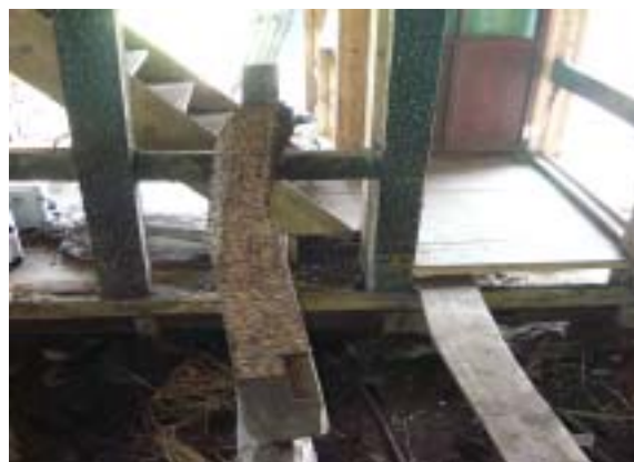
写真-1 作家による空き家改修(柱に彫刻を施す)
