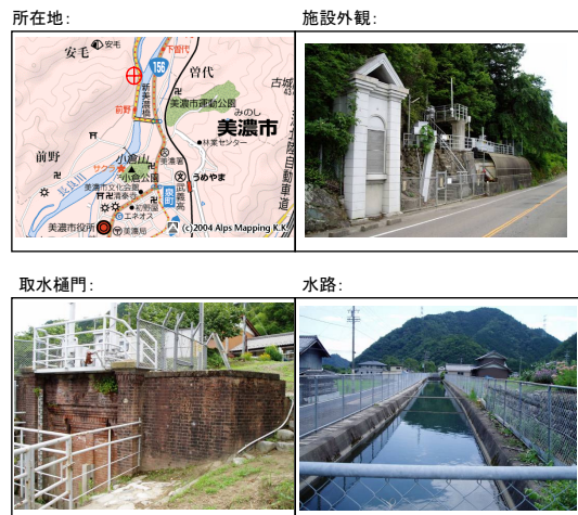
図-4 近代化遺産データベース(井ノ面発電所)
