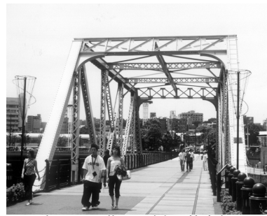
写真 - 2 港一號橋 (著者撮影)
