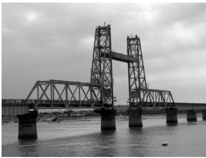
写真 - 1 筑後川昇開橋 (著者撮影)
