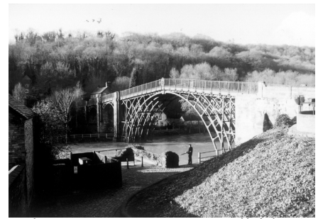
写真 - 3 The Iron Bridge (著者撮影)
