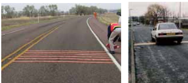
写真-1 ランブルストリップス（左:アメリカ 1) ）と THUMPS（右:イギリス 2) ）
