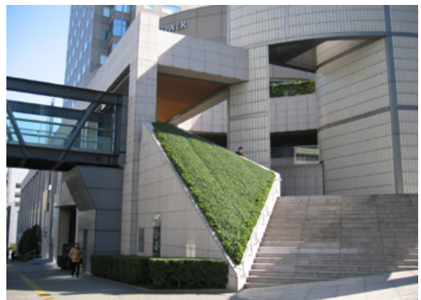
写真-3 事例12の部分写真。写真左側より右側の施設に歩道橋がそのまま入り込んでいる。
