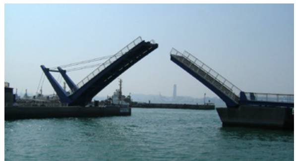
写真-2 事例10の開橋時全景写真。港湾の入り口のゲートになっている。
