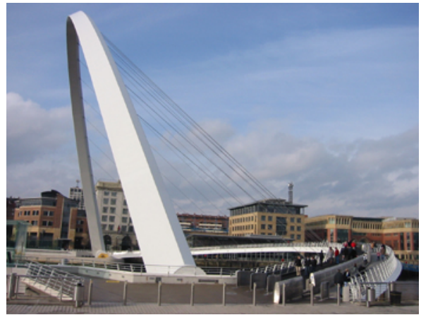
写真-1 事例20 側面の橋詰からの写真。遠景には再開発による建造物群が並ぶ。
