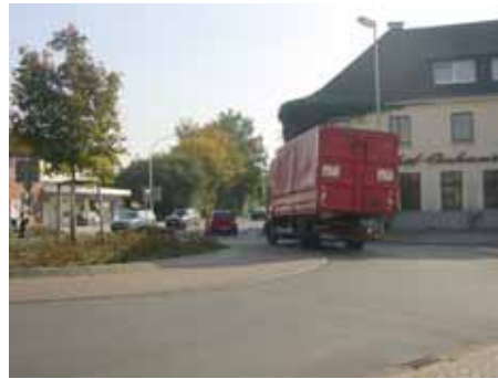
写真-2 エプロンに乗り上げる大型車
