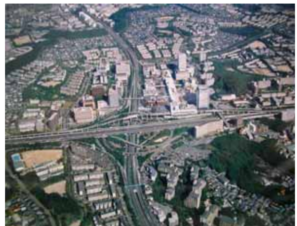
図 - 2 千里中央駅地区の全景
