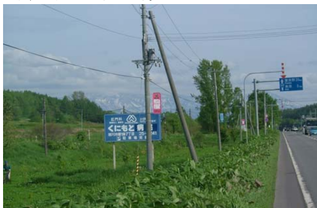
図-3 国道237号に設置されていた病院の固定広告物
