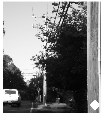
写真 -5 電力会社管理の電線（筆者撮影）
