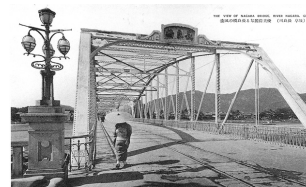
写真-2 鉄橋長良橋 11)
