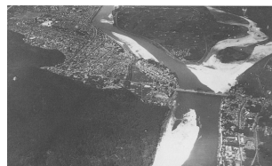
写真-3 締め切られる河川 11)
