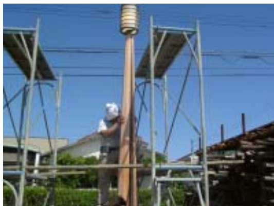
写真－４ 街灯の設置実験
