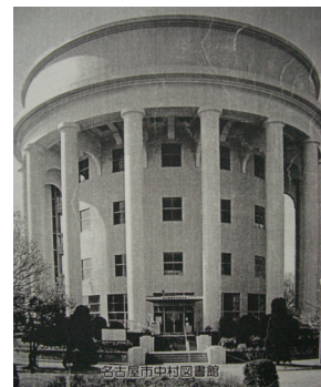
図-6 中村図書館に転用された稲葉地配水塔 (名古屋市演劇練習館 蔵)
