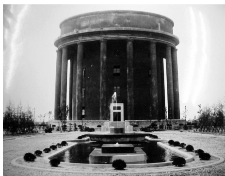
図-4 1937年竣工当時の稲葉地配水塔 (名古屋市演劇練習館 蔵)
