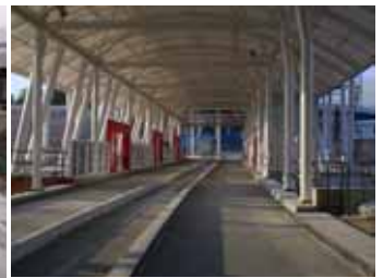
写真5 車体誘導設備
