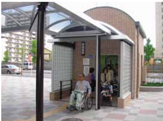
図 - 3 緑地公園駅構外エレベーター
