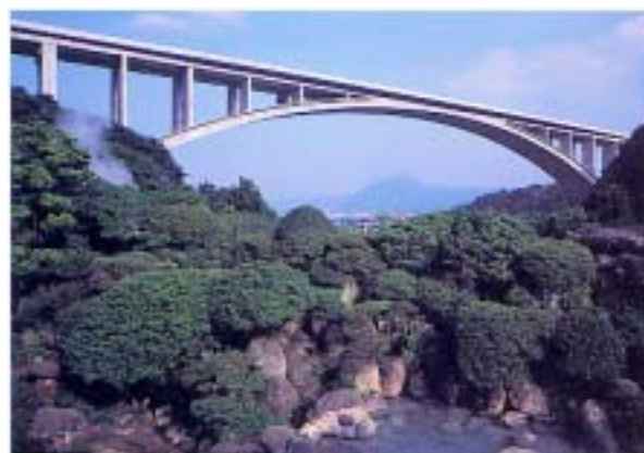
図-4 別府明善橋 8) (アーチ橋)
