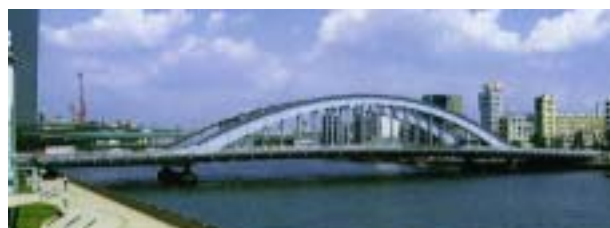
図-2 永代橋 7) (アーチ橋)
