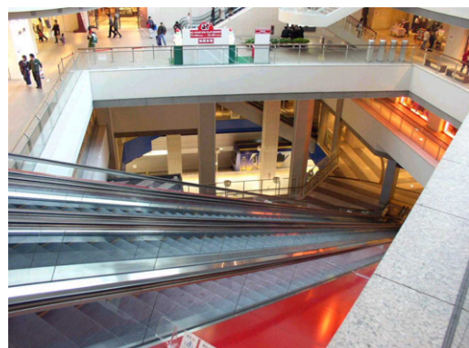
写真－1 吹き抜けで駅とビルが一体化 (みなとみらい駅)
