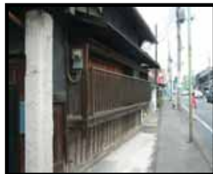
写真-4 現在の町並み
