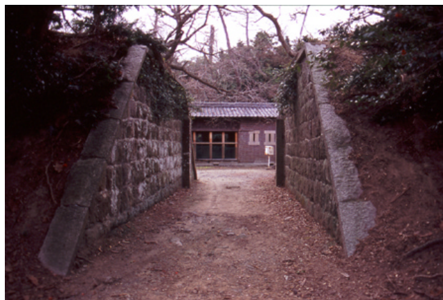
図 6 横目地の顕在化 (和歌山県友ヶ島第三砲台)
