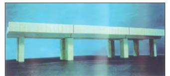
図 5-2 連続性を確保する提案の架道橋（RC ホロー桁）<sup>※2</sup>
