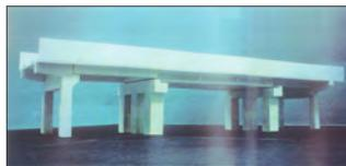
図 5-1 駅北架道橋原案（単純桁と桁受橋脚）<sup>※2</sup>
