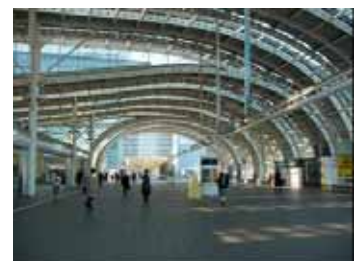
写真 - 2 橋上駅 明るく、開放的な空間
