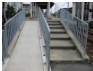
図9 額住宅前駅のスロープ
