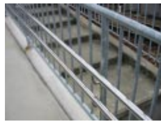
図10 額住宅前駅の手すり
