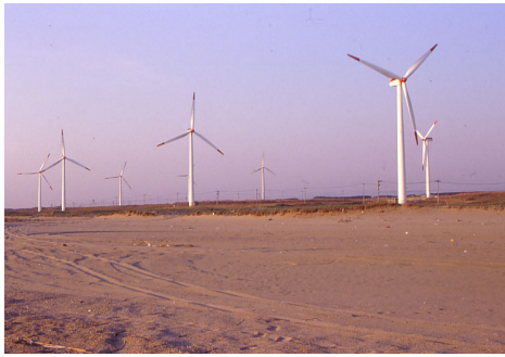
図 5 等間隔で配置された風車群（秋田市）
