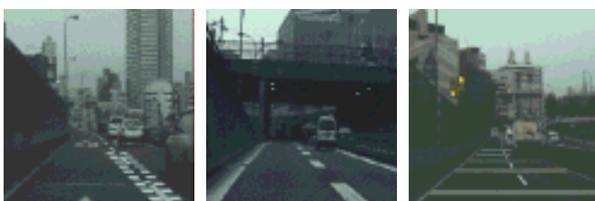
ドットマーキング塗装 幅広レーンマーク塗装 薄層塗装
