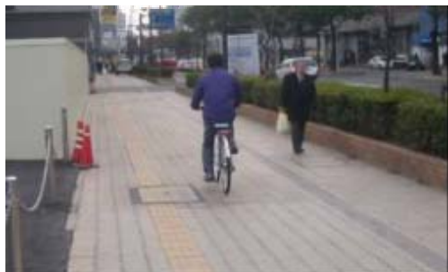
ブロック舗装自歩道
