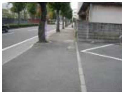
アスファルト舗装自歩道
