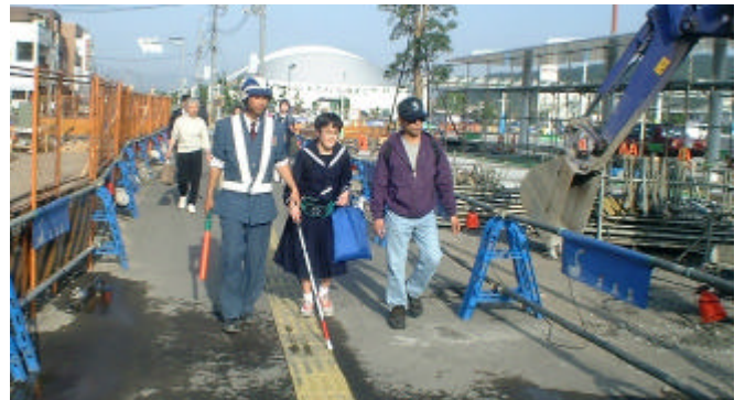
写真8 仮設通路・誘導ブロックと視覚障害者のエスコート
