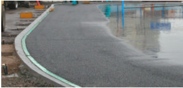
写真7 施工者からの提案で実施されたタクシー・一般車ロータリーの走行空間（W=2.5m）の排水性舗装 右側は通常の舗装で、左側が排水性舗装
