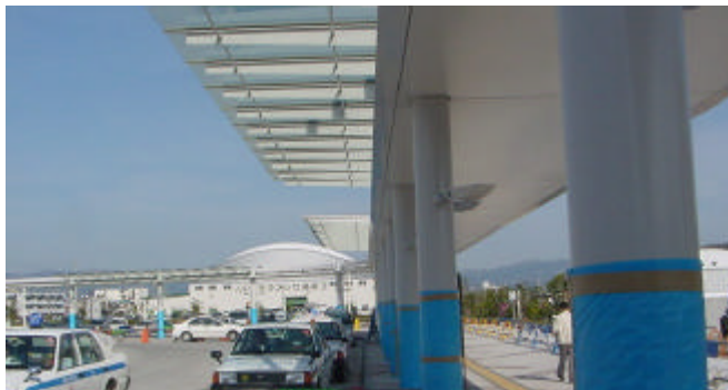
写真5 バス・タクシー乗場でのシェルターの車道への張出し
