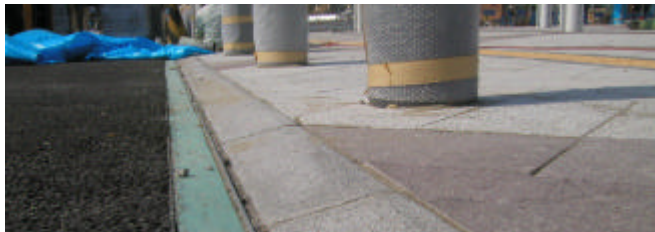
写真1 タクシー・一般車ロータリーの3cm段差と摺付
