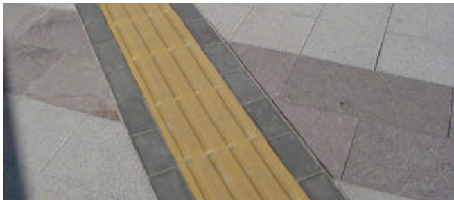
写真4 誘導ブロックに黒のサイドボーダーを設置して所要の輝度比を確保
