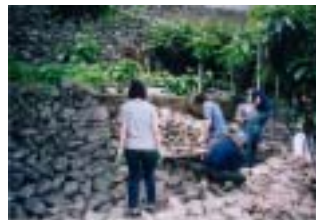
写真1 石積み作業風景
