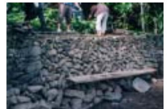
写真2 石積み完成時
