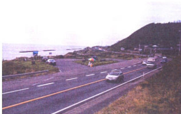
写真-2 もしもしピット整備地点
