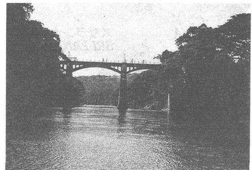
写真2 Peradeniya Bridge (撮影 1999.8)
