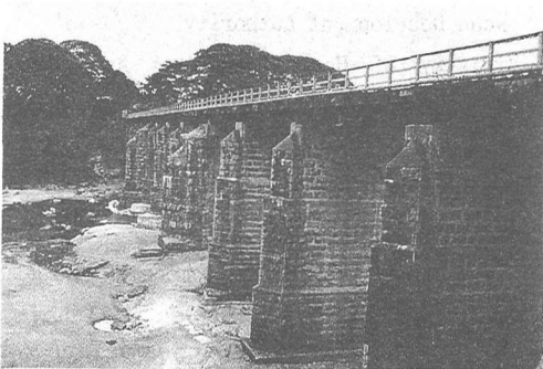
写真4 Daduru Oya Bridge (撮影 1999.8)
