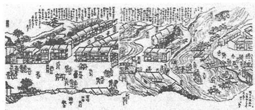
図-6 お土居の崩壊（「祇園社並旅所之図」より）
